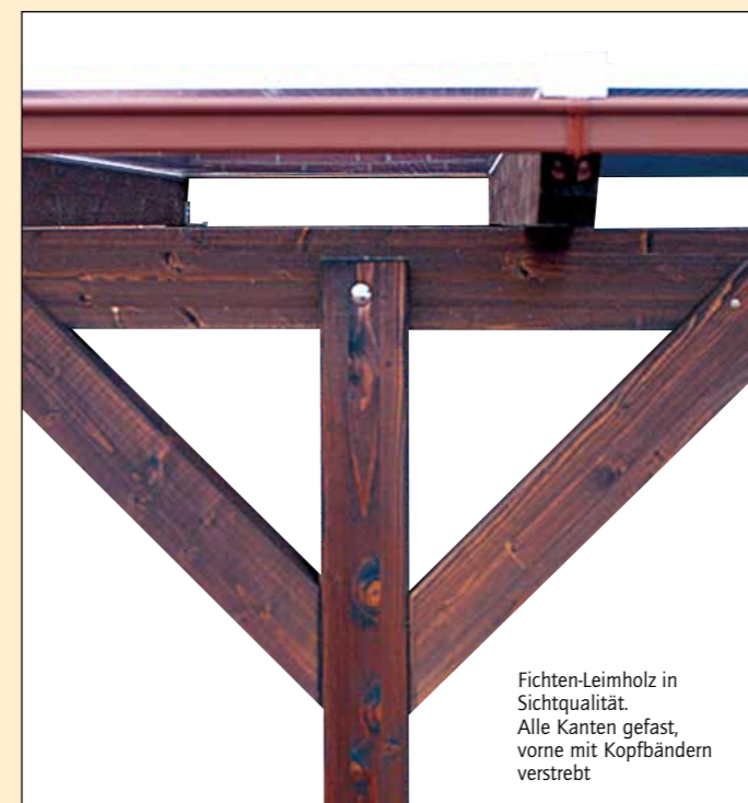
Seitlicher Dachabschluss aus Aluminium, um das Holz gegen Regenwasser zu schützen
